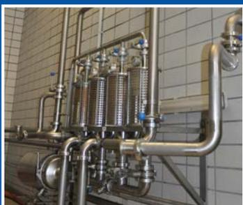
■ Wir von Heinr. Leicht verfolgen beim Rohrleitungsbau eine möglichst weitreichende Vorfertigung im Haus. Paneel und Anschlusskomponenten werden vormontiert zum Kunden ausgeliefert.
