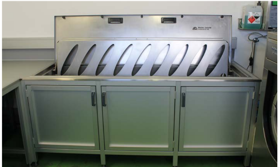
Eingebautes Spineboardbecken in der Arbeitsfläche.
