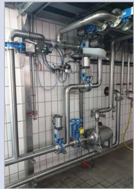
Verrohrung vom Laugeabsetztank in DN 40 / 50 / 80 und 100
