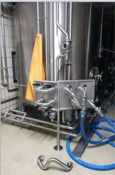
CIP-Bogen DN 50 am Paneel
