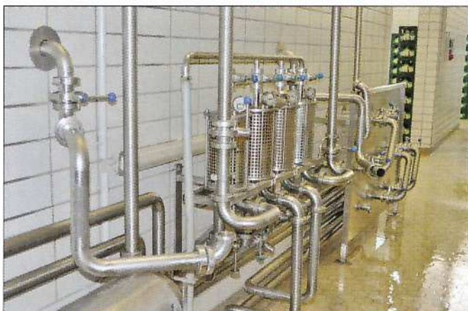
Zentrales Paneel und Verschneidbock mit Anschluss aller Brauerei-Abteilungen
