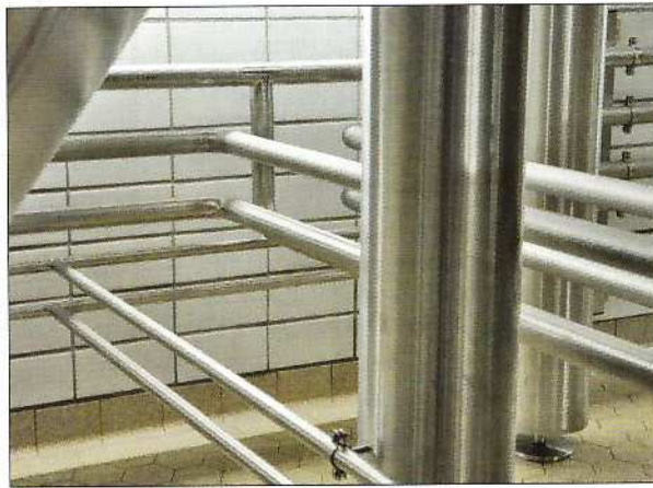
Die Firma Heinrich Leicht übernahm die kompletten Rohrleitungsarbeiten.
